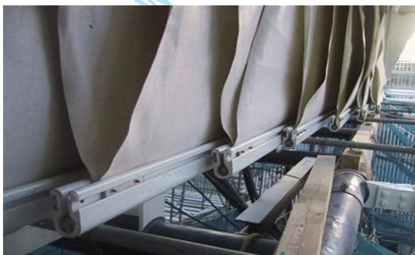
附图 6-113 折叠式膜结构下节点
