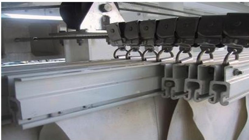
附图 6-112 折叠式膜结构上节点
