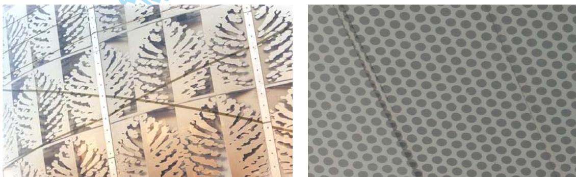
附图 6-100 ETFE 膜材表面颜色及图案示例
