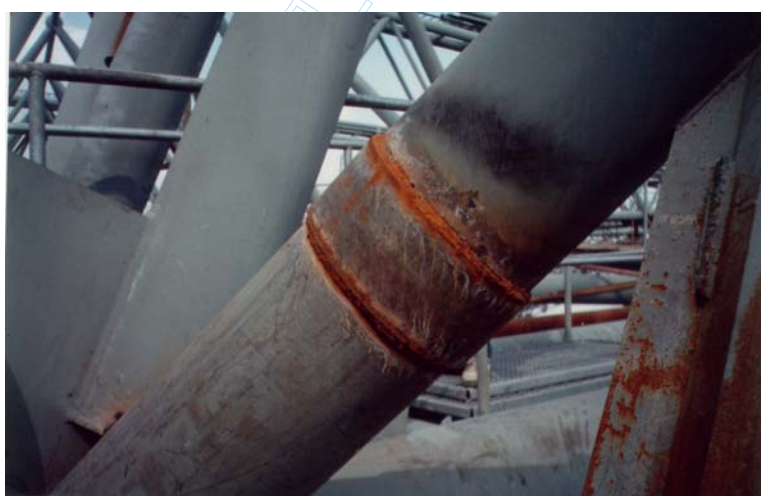
(e) 管-套管-管 加固、加长连
