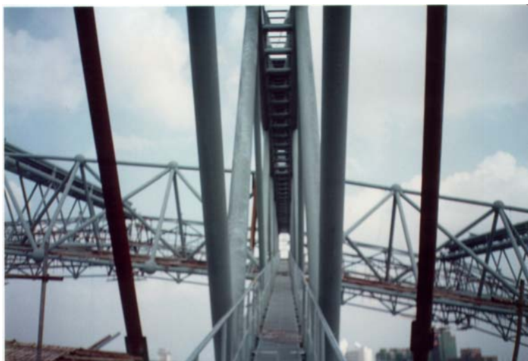
(f) 纵向主桁架 + 环向桁架梁 相交连
