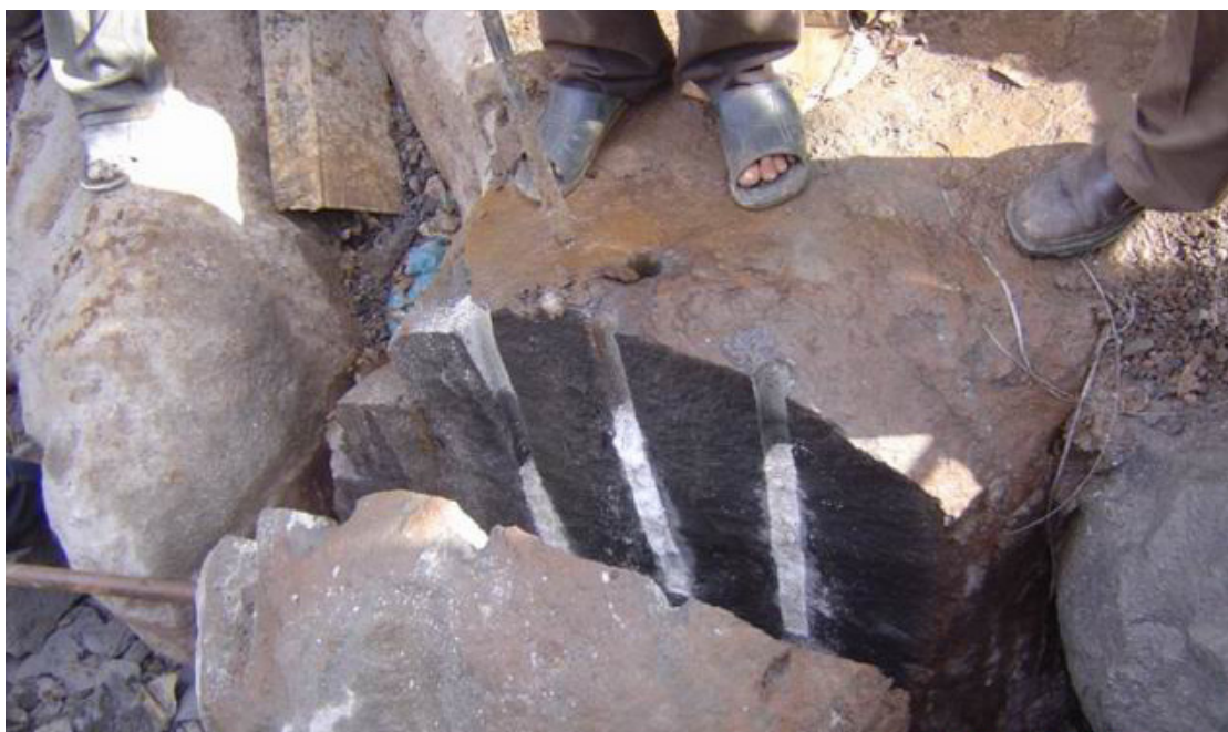
图 13-2-5 静态拆除状态图
