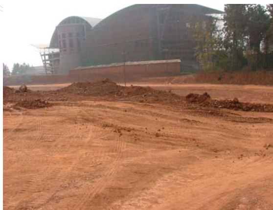
图 2-5 施工临时用电由此引入
