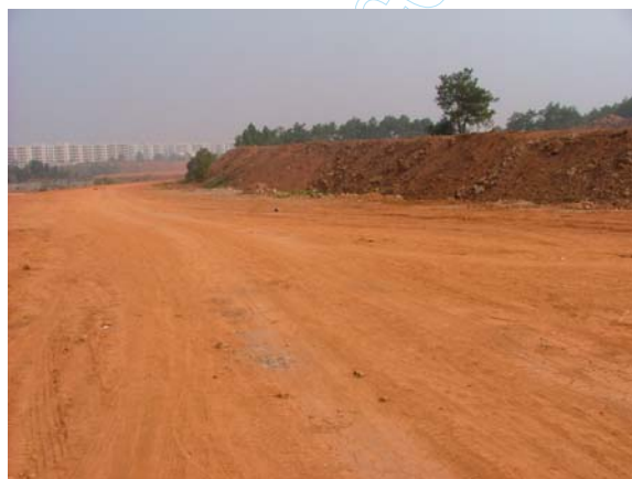
图 2-3 施工道路已修通
