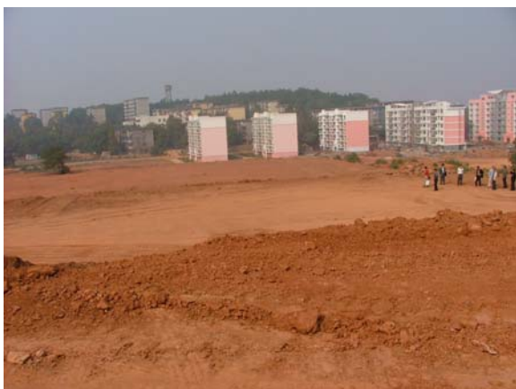
图 2-2 施工场地已平整
