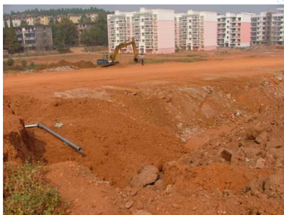
图 2-4 施工临时用水即将接通
