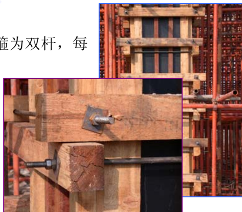
图 12-2 框架柱方形柱模板
